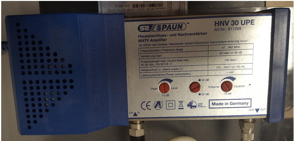
Slika 3.4 Pojačalo signala
