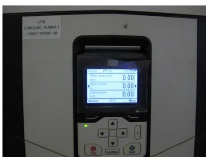
Slika 3.56. Regulator za cirkulac. pumpu 1
