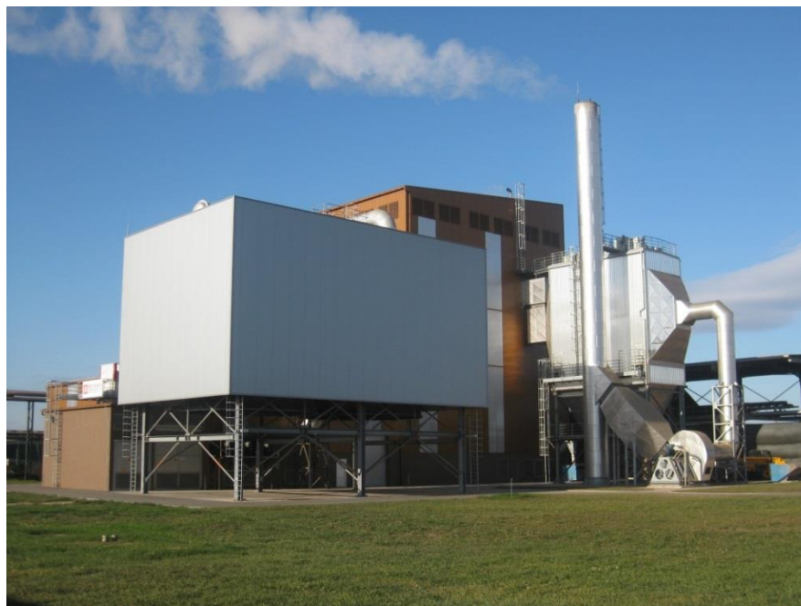
Slika 2.3. Elektrana na biomasu " Slavonija OIE"
