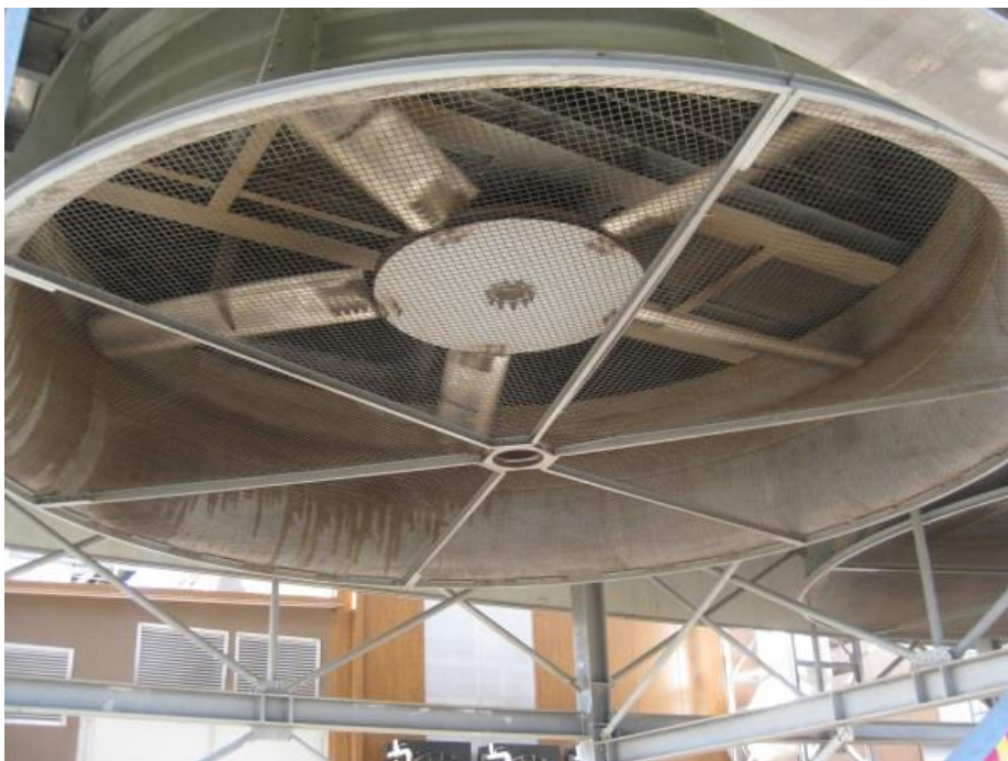
Slika 3.32. Zračni kondenzator 1
