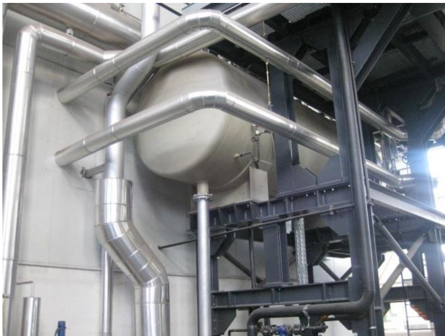
Slika 3.30. Spremnik kondenzata
