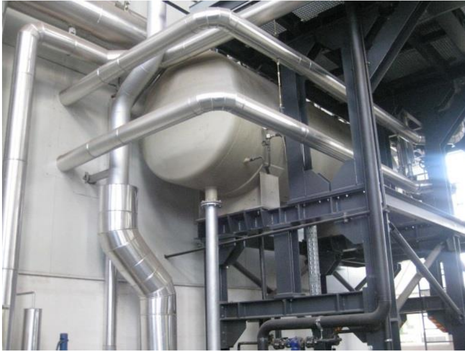
Slika 3.30. Spremnik kondenzata
