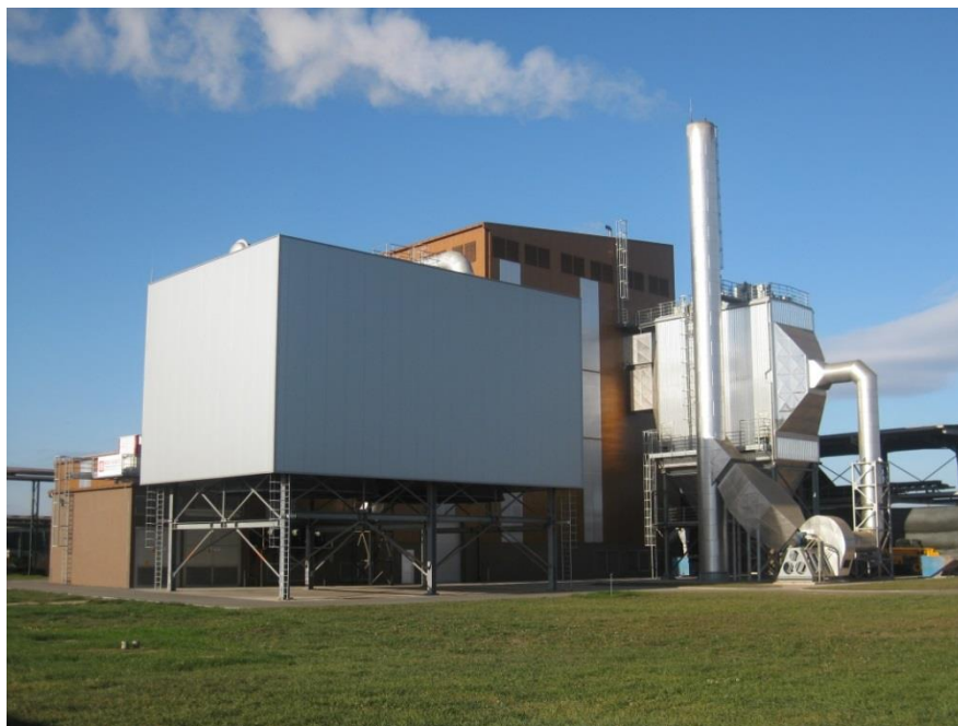
Slika 2.3. Elektrana na biomasu " Slavonija OIE"
