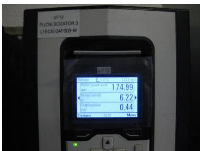
Slika 3.49. Regulator pužnog dozatora 3
