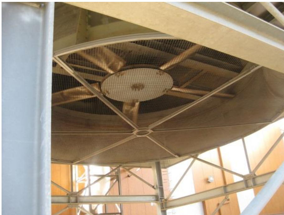
Slika 3.33. Zračni kondenzator 2
