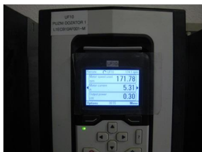
Slika 3.47. Regulator pužnog dozatora 1
