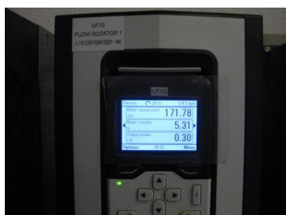
Slika 3.47. Regulator pužnog dozatora 1
