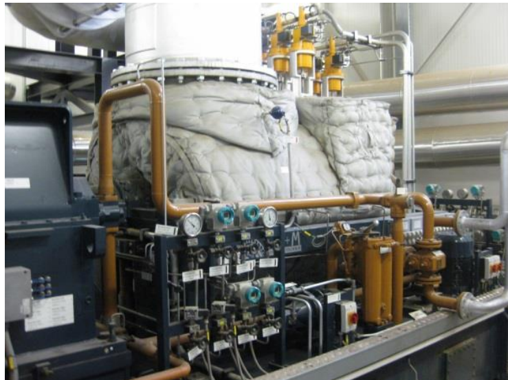
Slika 3.22. Parna turbina u elektrani
