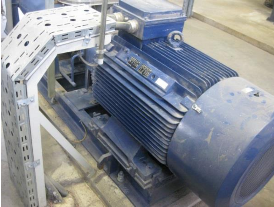
Slika 3.37. Napojna pumpa
