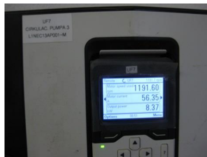
Slika 3.58. Regulator za za cirkulac. pumpu 3
