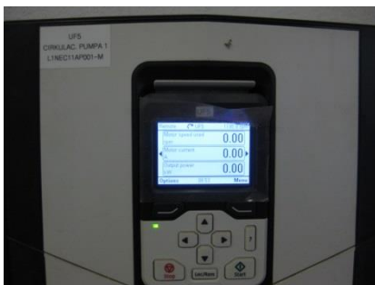
Slika 3.56. Regulator za cirkulac. pumpu 1
