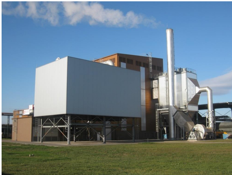
Slika 2.3. Elektrana na biomasu " Slavonija OIE"
