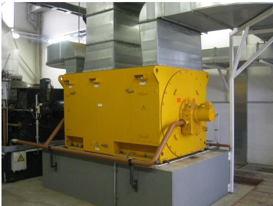
Slika 3.29 Trofazni sinkroni generator
