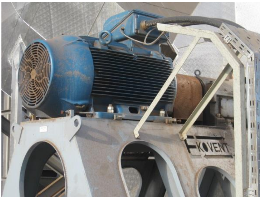
Slika 3.43. Motor odsisnog ventilatora
